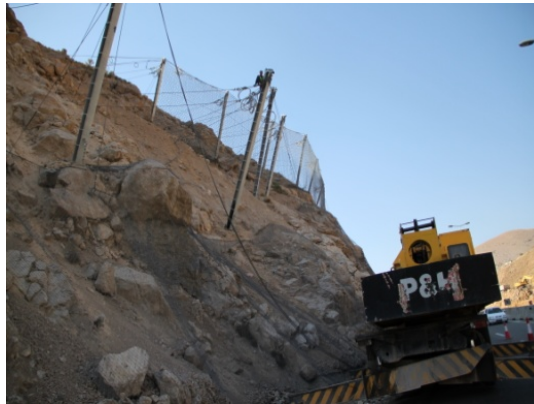
شکل (۱-۳) نصب حفاظ سنگ‌گیر (محور هراز-پائیز ۹۱)
