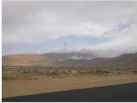
شکل (۳-۳) اجرای سیستم روشنایی در گردنه های مه گیر و استفاده از چراغ های بخار سدیم (منطقه گدوک-زمستان ۹۰)
